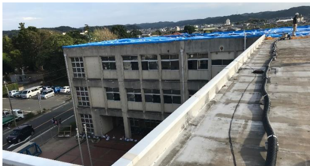
普通教室棟 屋上
